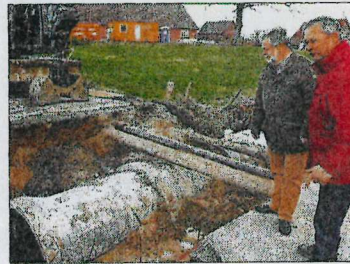
Bürgermeister Rainer Holtz (l.) und Thorsten Lorenzen begutachten den Bau des Durchlassrohres.
